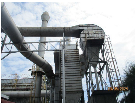
ภาพที่ 2-1 ระบบรวบรวมฝุ่นแบบ Canopy hood
