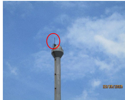
ภาพที่ 2-5 ระบบป้องกันฟ้าผ่าบริเวณปลายปล่อง
